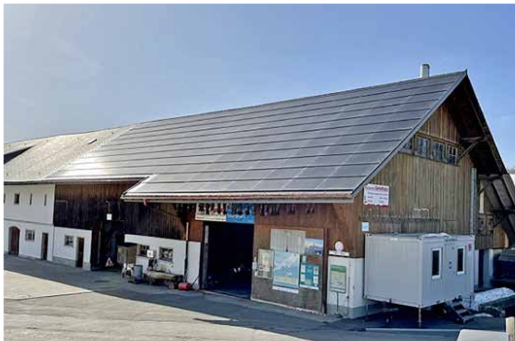
Mit der Dachsanierung wurde eine Photovoltaik-Anlage realisiert.
