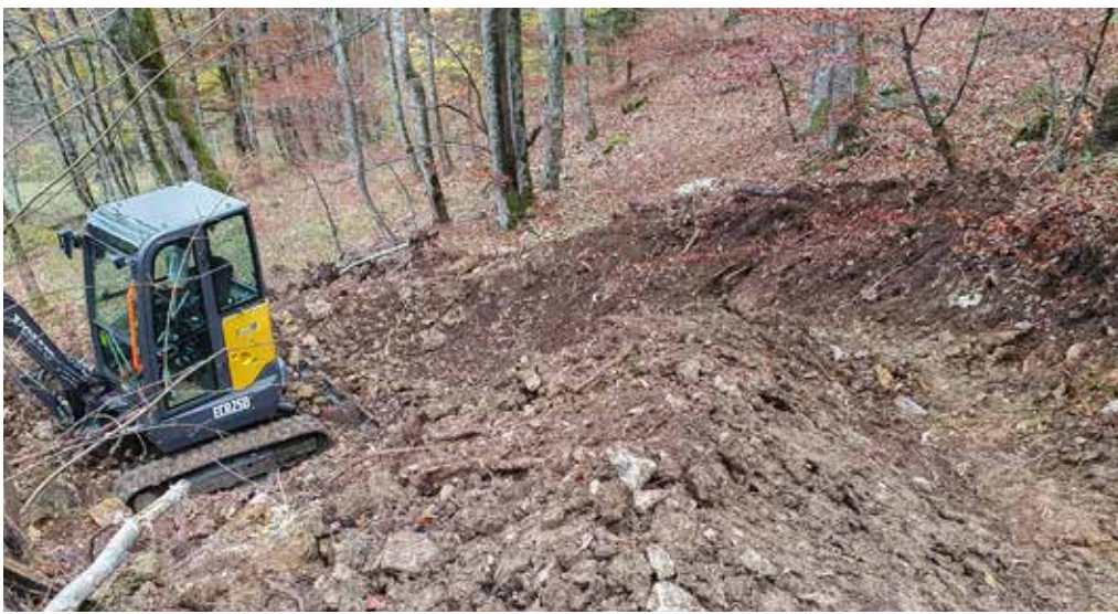
An einem normalen Arbeitstag können 100 Meter der neuen Trail-Strecke realisiert werden.
